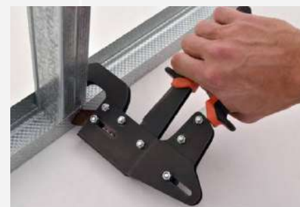
Крепление НПП к ПП с помощью просекателя или саморезов с прессшайбой
